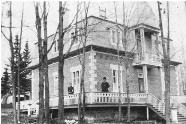
Presbytère au temps du curé Olivier Martin, premier prêtre de Saint-Thuribe. Source : Saint-Thuribe, 1898-1998, d'hier à aujourd'hui , p. 20.
