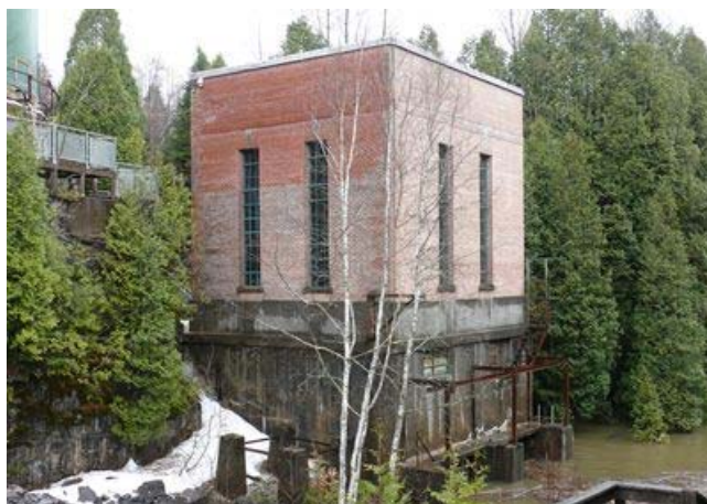
Ancienne centrale hydroélectrique Saint-Alban 2.
