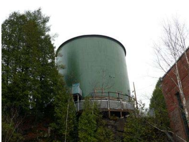
Ancienne centrale hydroélectrique Saint-Alban 2 et cheminée d'équilibre.
