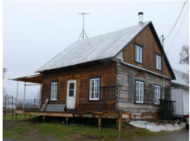
Maison sise au 170, rang de la Rivière-Blanche. Maison en pièces sur pièces assemblée en queue d'aronde. Ce type de construction est très répandu au 19 e siècle dans la construction des maisons rurales.
