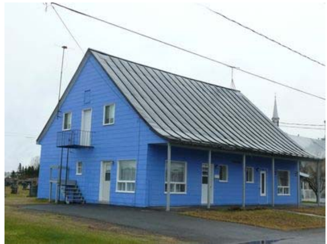
Premier presbytère construit vers 1859-1861, déménagé de son site initial et converti en logements, 24-28, rue Saint-Eugène.
