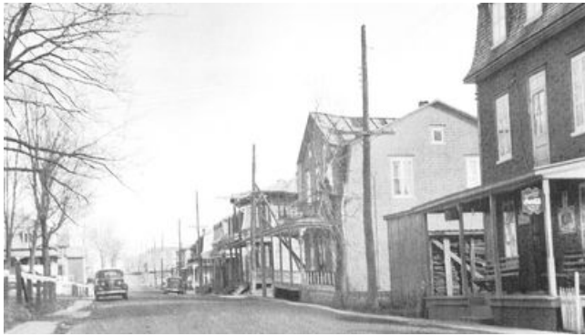
Rue Principale. Source : Une histoire d'appartenance , p. 171.
