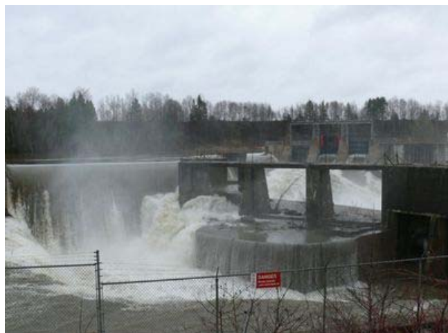
Vestiges de la centrale Saint-Alban 1.
