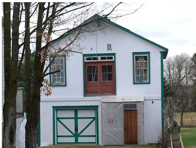
Ancien atelier de menuiserie derrière une maison du village de Saint-Thuribe qui aurait aussi eu une forge à l'intérieur.
