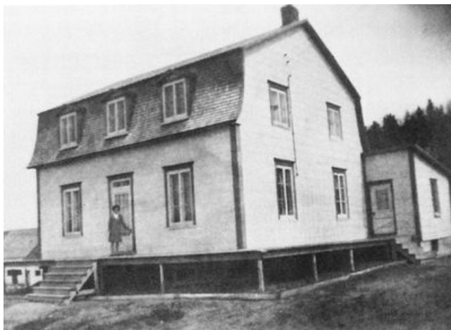
Maison de ferme probablement bâtie en 1908. Source : Saint-Ubalde, 1860-2010 , p. 380.
