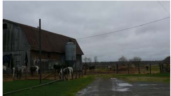
Ferme en bordure de l'avenue Principale.
