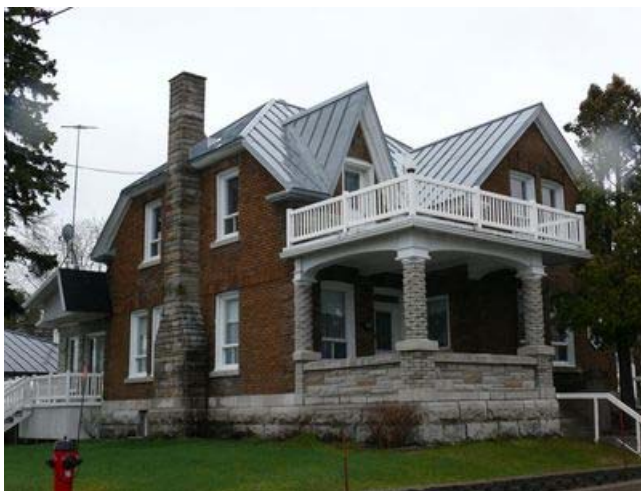
Premier presbytère modifié et transformé en résidence, 1105-1109, avenue Principale.
