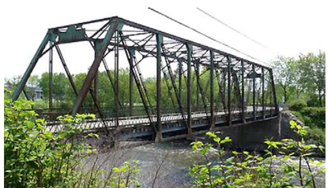
Pont Gouin à Saint-Casimir.
