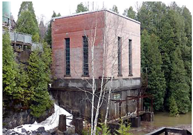
Centrale hydroélectrique de Saint-Alban 2.
