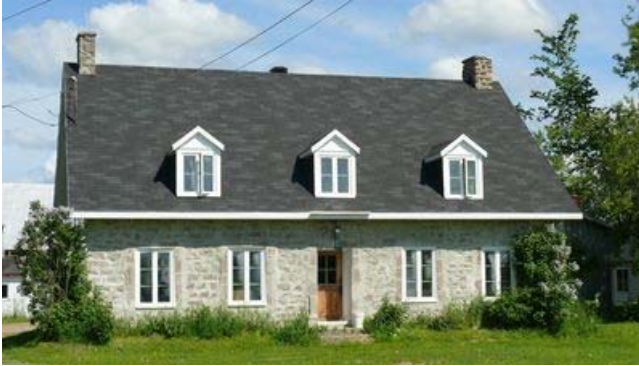
Selon certaines sources, la maison Delisle aurait été construite vers 1648 par le maître maçon Paul Chalifour pour François de Chavigny de Berchereau, premier seigneur de la seigneurie de Deschambault, alors nommée seigneurie de Chavigny. La demeure est incendiée lors de l'invasion britannique, puis reconstruite vers 1765.
