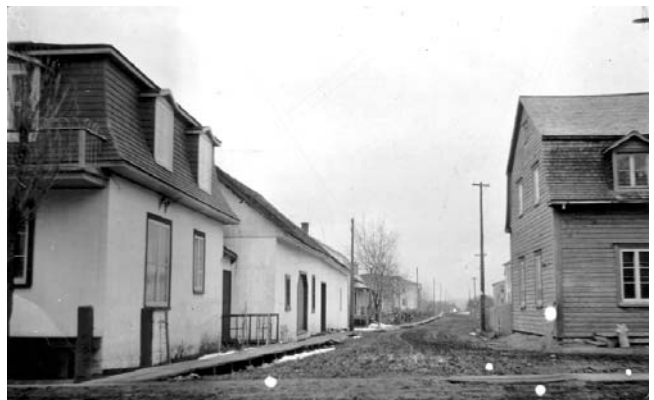
La rue Saint-Philippe à Saint-Alban en 1917. Le grand bâtiment en bois est probablement une écurie. Source : CARP.
