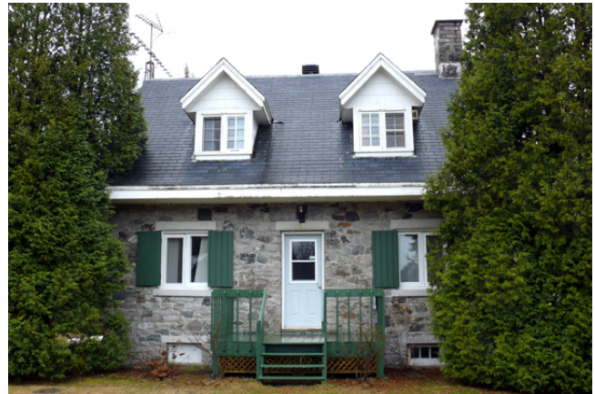
Maison du gardien au 2, rang de l'Église Sud, Saint-Alban,
