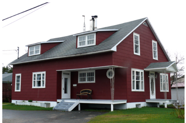
Maison au 36, rue Saint-Philippe à Saint-Alban.
