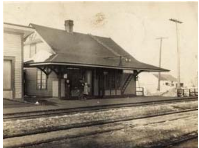
Gare de Grondines. Source : BANQ. Il n'est pas possible de confirmer la date de construction de cette gare de Grondines et quelle ligne de chemin de fer elle desservait.
