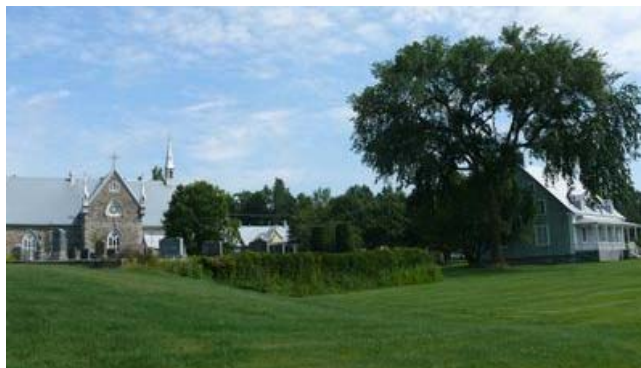
Presbytère, église et cimetière du secteur Grondines.
