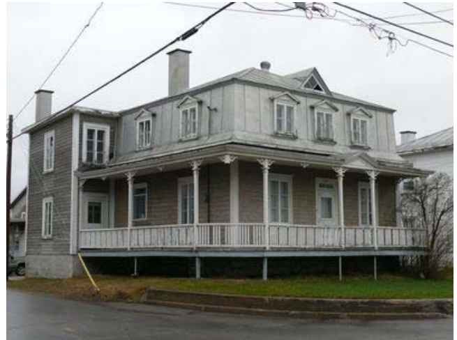
984, avenue Principale. Les tôles du brisis sont fixées en leur centre avec des rivets.
