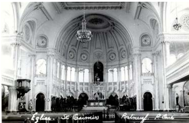
Intérieur de l'église. Source : BAnQ.
