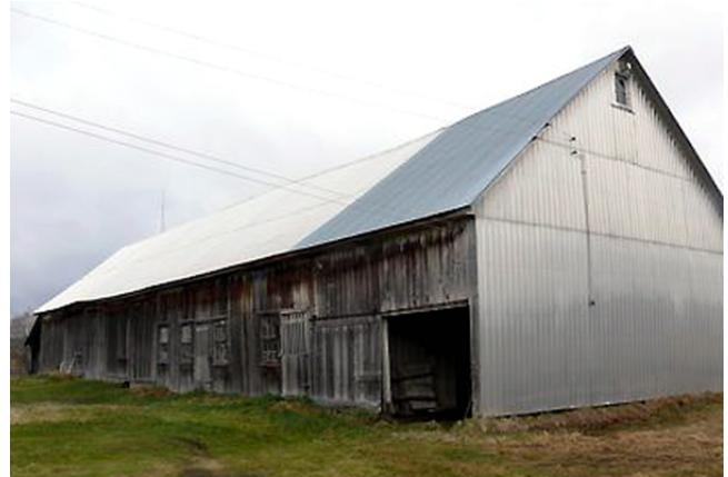
Grange-étable à toiture à deux versants droits, rattachée au 1205, rang Sainte-Anne à Saint-Casimir.
