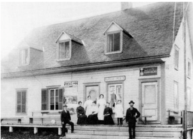
Magasin Filteau. Source : Saint-Ubalde, 1860-2010 , p. 382.
