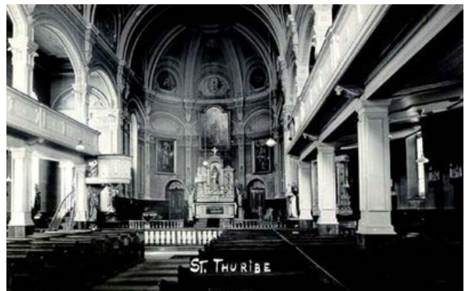
Intérieur de l'église. Source : BANQ.
