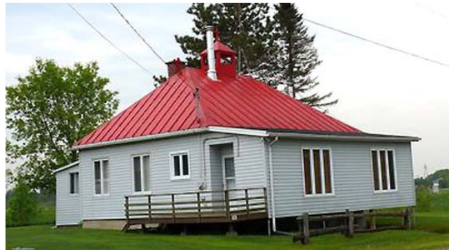
Ancienne école dans le rang du Rapide Sud à Saint-Casimir.
