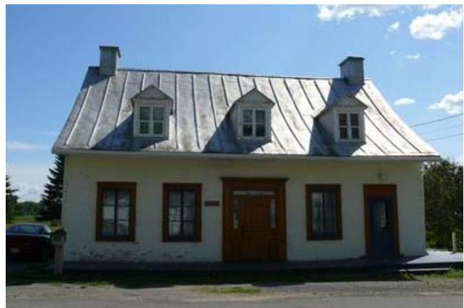
745, du Faubourg. Avec ses deux portes en façade, cette maison du faubourg laisse à penser qu'elle aurait pu servir de magasin général.
