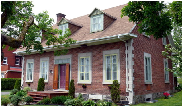
Châinages d'angle et chambranles en pierre de Saint-Marc sur une maison en brique de Saint-Casimir.
