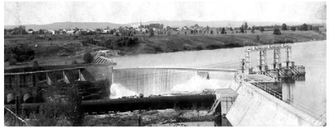
Vue du barrage et du village de Saint-Alban. Source : Collection Action plans d'eau plein air.
