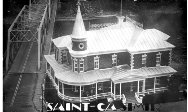
Maison de Philippe Grandbois à Saint-Casimir. Source : BAnQ.
