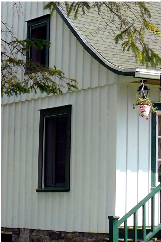
Planches verticales à couvre-joint.
