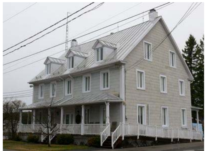
Deuxième presbytère construit en 1890, maintenant une résidence privée sise au 188, rue Principale.
