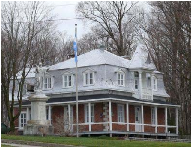
Ancien presbytère de Saint-Thuribe, 375, rue Principale.
