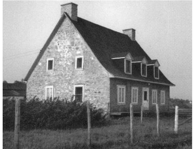
Maison Paquin. Peut-être construite vers la fin du 18 e siècle ou au tout début du 19 e siècle, il s'agit d'une maison d'une famille d'agriculteurs à l'aise du 2 e Rang. Source : Deschambault au fil du temps , p. 32.
