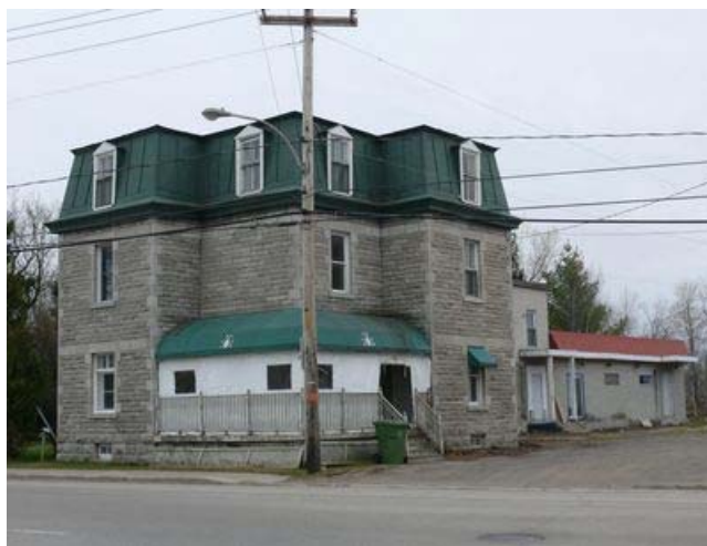
Ancien hôtel Perreault au 499, boulevard Bona-Dussault situé tout près de l'avenue Principale.
