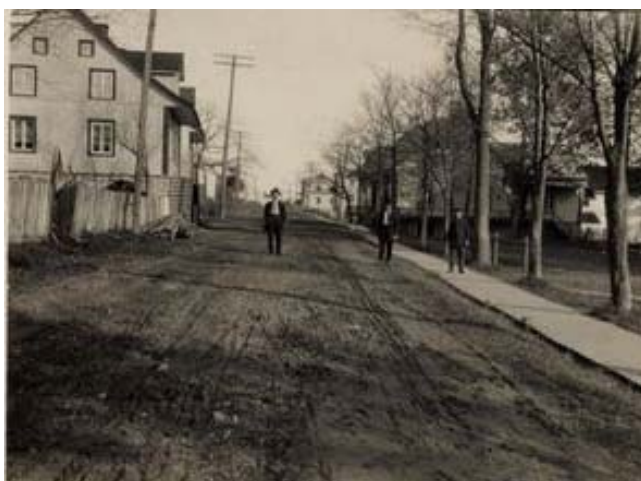
Route principale à Grondines, tout près de l'église. Source : BAnQ.
