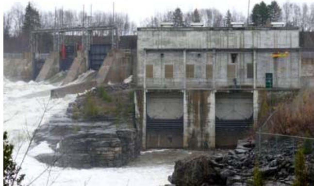
Vestiges de la centrale Saint-Alban 1.
