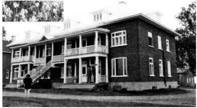
Unité de logements de la Ferme-École. Source : La station de recherche de Deschambault , p. 33.
