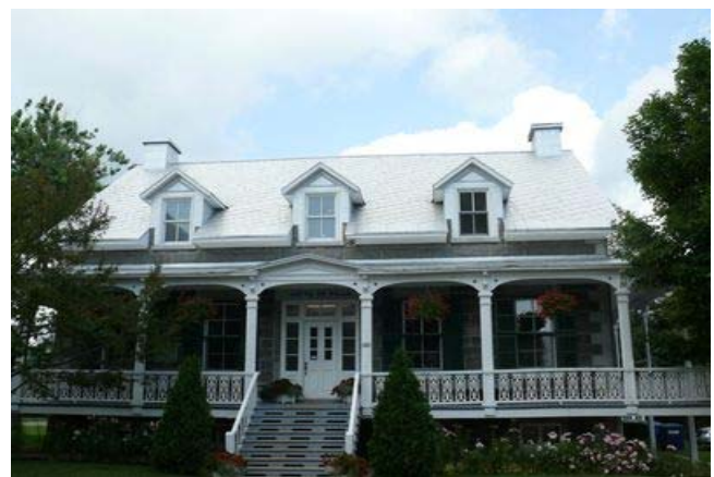
Troisième presbytère de Deschambault commencé en 1871 et transformé en hôtel de ville, 120, rue Saint-Joseph. Œuvre de Zéphirin Perrault.
