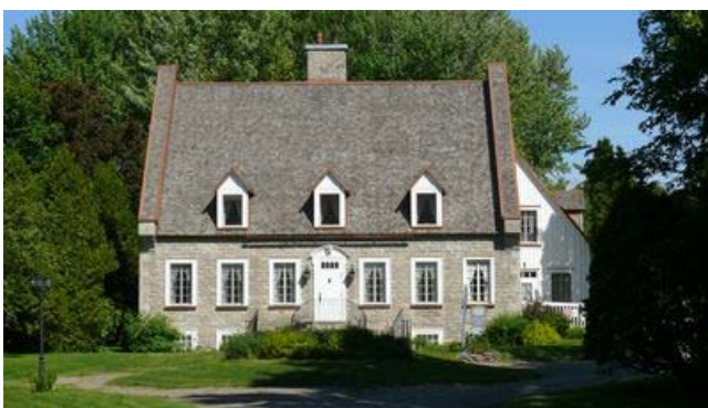
La maison Jean-Boudreau est construite vers 1790 sur les terres de l'ancien domaine seigneurial de Deschambault pour Jean Boudreau.
