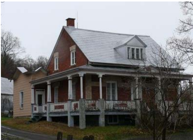
Maison située au 60, rang de la Rivière-Blanche. La lucarne double (lucarne unique percée de deux baies) est typique à la région riveraine du Saint-Laurent et on la retrouve dans plusieurs villages de la région de Portneuf.
