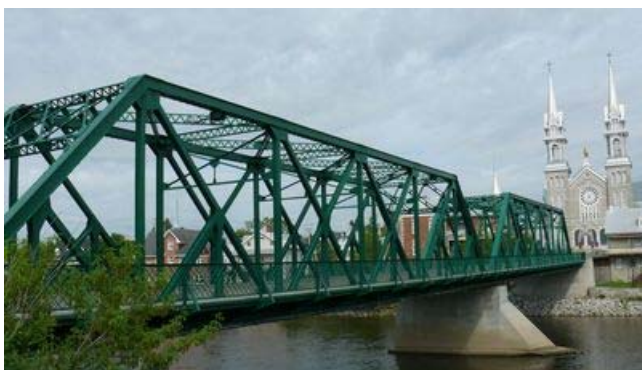
Pont à la hauteur de l'église.
