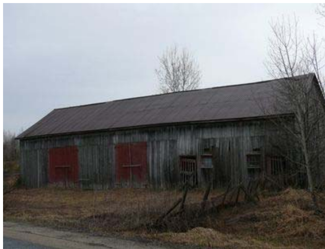
Grange du 1433, rang Saint-Paul Nord.
