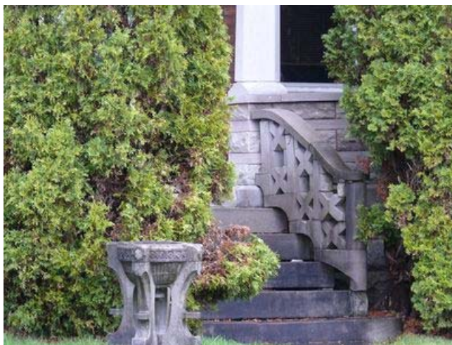
Balustrade en pierre taillée par Adélaré Vézina au 750, avenue Principale.
