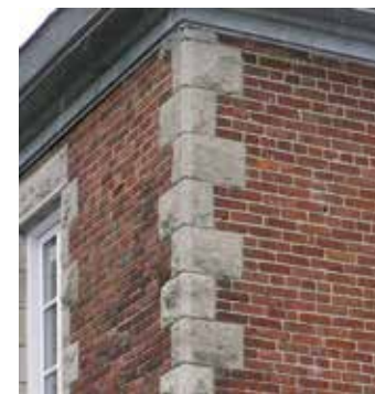
Chaînage d'angle
