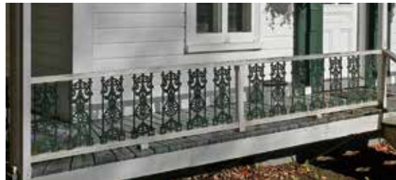
Garde-corps avec balustres en fonte, Saint-Thuribe
