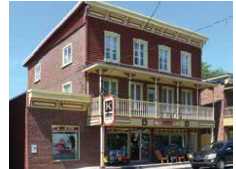
Édifice commercial, Saint-Raymond
