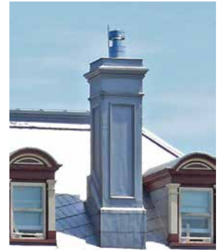
Cheminée recouverte de tôle ouvragée, Neuville
