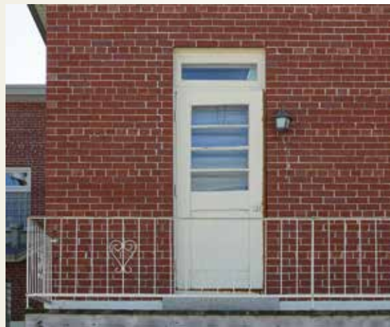
On reconnaît la brique structurale sur l'hôtel de ville par ses rangées de briques en boutisse et en panneresse qui se succèdent, Saint-Raymond
