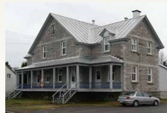
Ce bâtiment de Saint-Marc-des-Carières est revêtu de pierre calcaire extraite localement.
