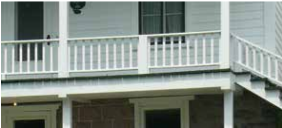
Garde-corps en bois avec barrotins carrés, Saint-Casimir
