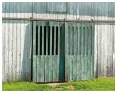
Portes ajourées servant à l'aération de l'étable, Cap-Santé
