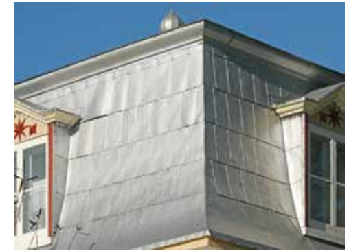
Tôle en plaques recouvrant le brisis d'une toiture mansardée, Saint-Casimir
