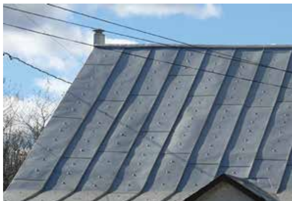
Toiture en tôle rivetée, Saint-Marc-des-Carières
