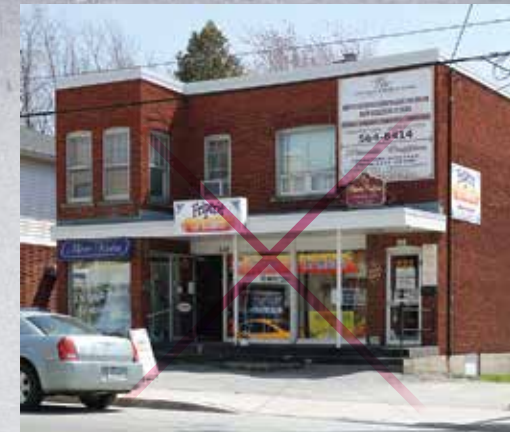
Perte de contrôle en matière d'affichage avec enseignes disparates et mal positionnées. À éviter
