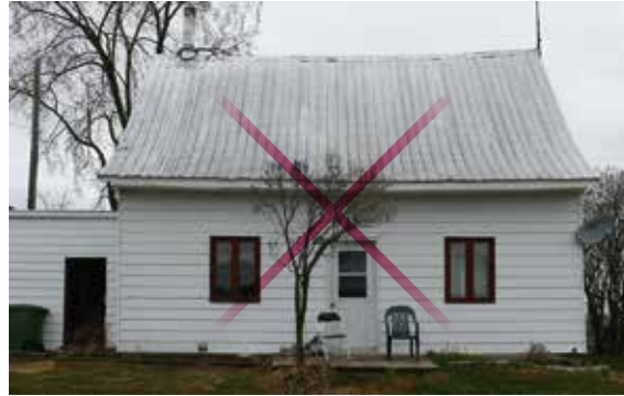
Maison revêtue d'un parement de fibre de bois pressée (Masonite)
