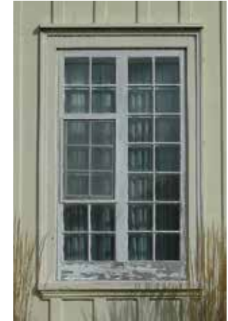
Fenêtre à battants à petits carreaux, Deschambault
