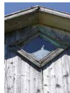
Fenêtre losangée, Cap-Santé
