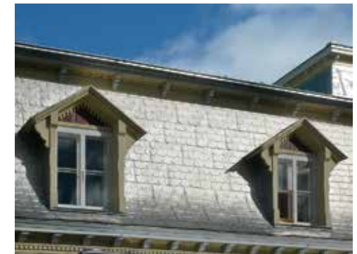
Tôle embossée recouvrant le brisis d'un toit mansardé, Neuville
