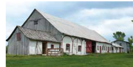
Grange-étable à toit à deux versants à base légèrement recourbée, Pont-Rouge
