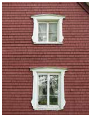
Modèle de chambranle typique de Pont-Rouge
