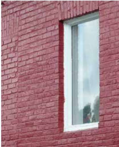
Mur de brique qui a été peint afin de camoufler des ouvertures murées. Généralement, ce type d'intervention est à éviter.
