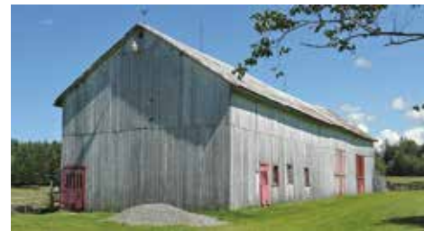
Grange-étable à toit à deux versants droits, Portneuf
