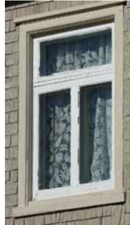
Fenêtre à battants et à imposte, Saint-Casimir
