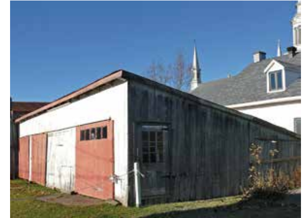
Garage-hangar situé dans la cour arrière d'une résidence, Saint-Alban
