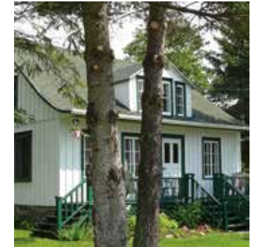
Maison revêtue de planches à couvre-joint, Grondines
