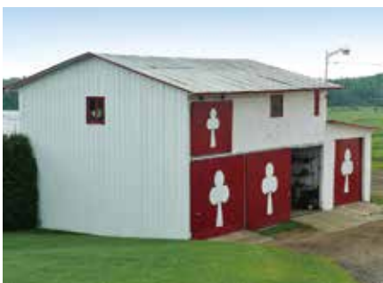
Portes coulissantes sur rail ornées de motifs, Saint-Léonard-de-Portneuf
