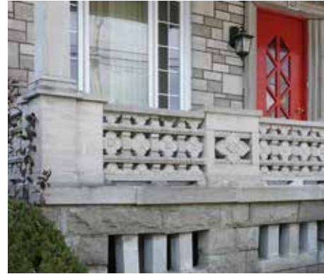
Garde-corps en pierre calcaire sculptée, Saint-Marc-des-Carières
