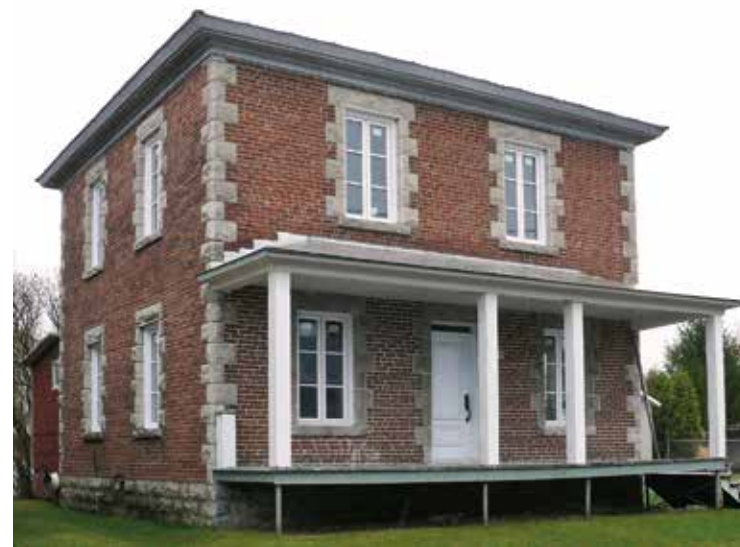
Maison construite en brique et dotée de chaînages d'angle en pierre, Saint-Marc-des-Carières
