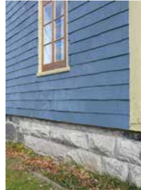
Fondation en pierre de taille, Deschambault
