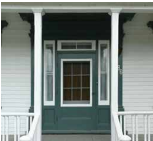
Porte dotée d'une imposte et de baies latérales et encadrée d'un portail, Deschambault
