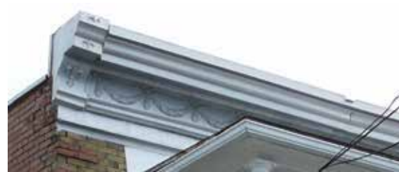
Corniche ouvragée en tôle, Donnacona
