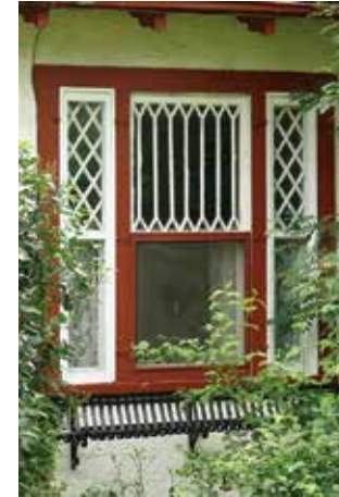
Fenêtre à guillotine avec baies latérales, Neuville
