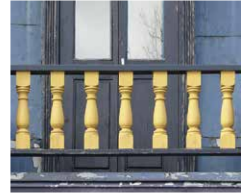
Garde-corps avec balustres tournés, Deschambault
