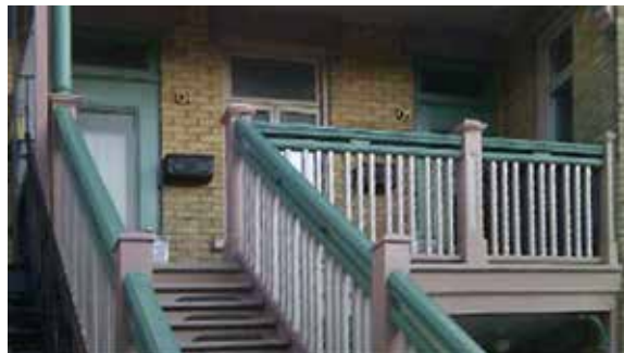
Deux principales manières de surhausser un garde-corps à 42 pouces : 1) L'ajout d'une base pleine sous le garde-corps existant (photo du haut); 2) L'ajout d'une deuxième main courante dans la partie supérieure (photo du bas).
