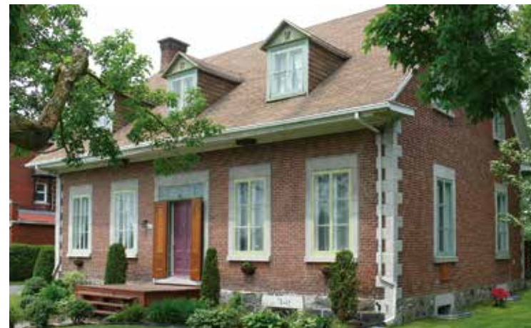
Maison en brique dotée de chaînages d'angle en pierre, Saint-Casimir
