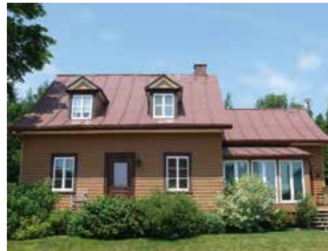
Maison coiffée d'une toiture en tôle à baguettes, Grandines
