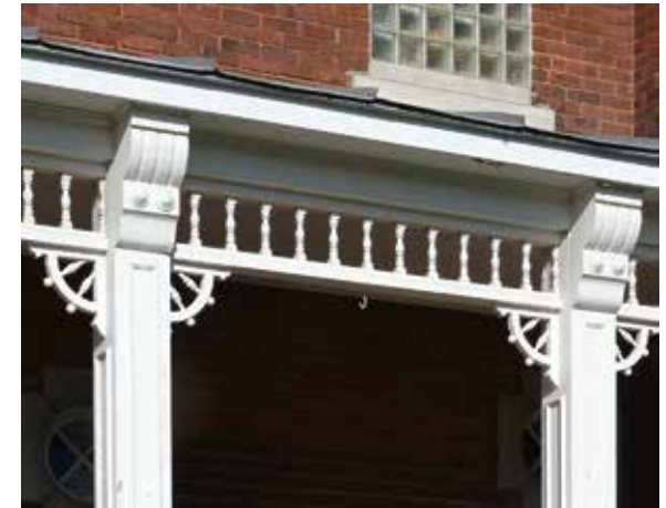
Lambrequin ornant la partie supérieure d'une galerie, Saint-Marc-des-Carrières
