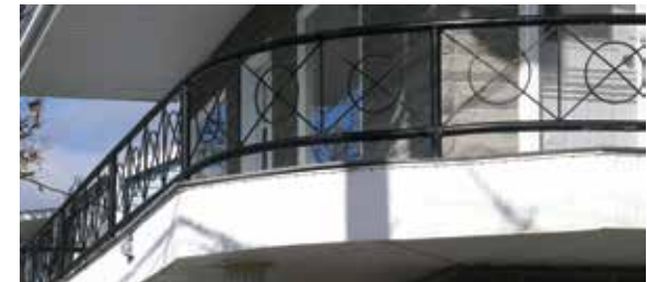
Garde-corps en fer ornemental, Saint-Marc-des-Carières
