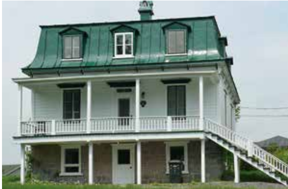
Exceptionnellement, certaines maisons sont assises sur de hautes fondations permettant l'aménagement d'un atelier ou d'un commerce, Saint-Casimir
