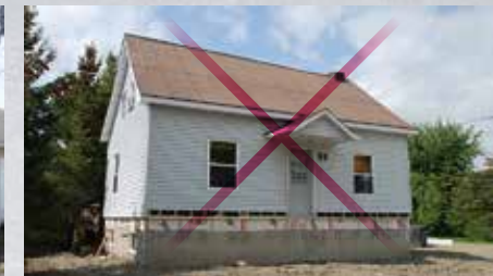
Nouvelle fondation en béton trop haute qui modifie de façon importante la volumétrie de la maison. À éviter
