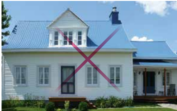
Maison revêtue d'un parement de vinyle
