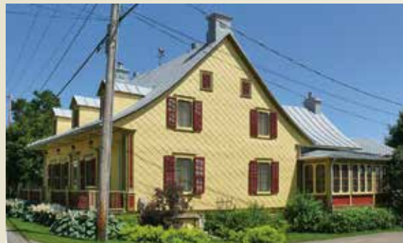
Maison revêtue de bardeaux d'amiante-ciment losangés, Grondines
