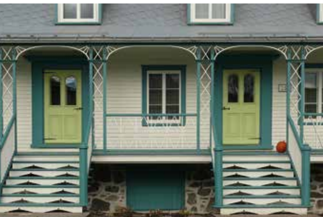
Galerie et escaliers, Deschambault
