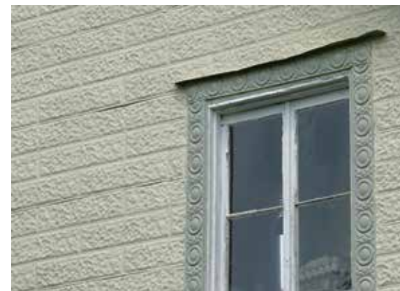
Magnifique chambranle de tôle embossée posé sur un revêtement de même nature imitant la pierre, Saint-Basile
