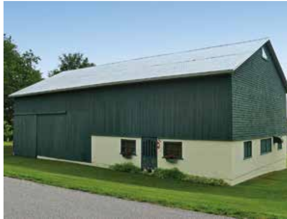
Grange-étable au revêtement différencié, Neuville
