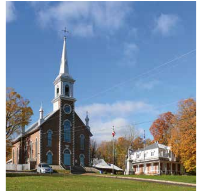
L'église et le presbytère de Saint-Thuribe sont revêtus de briques fabriquées dans une briqueterie aménagée directement sur le chantier en 1898 et 1899.
