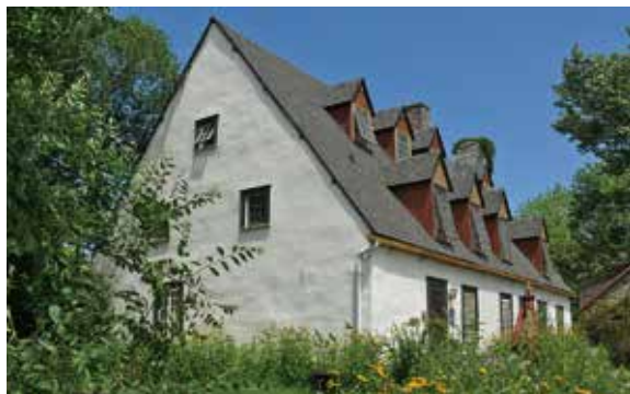
Maison en pierre revêtue d'un enduit destiné à protéger la maçonnerie des intempéries, Neuville
