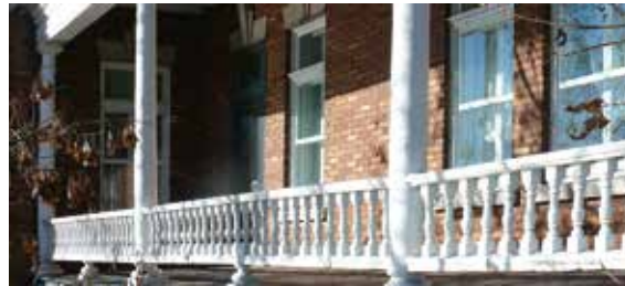
Garde-corps en bois avec barrotins tournés, Saint-Casimir
