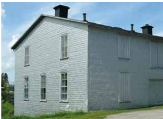
La tôle embossée est ici utilisée pour recouvrir les murs extérieurs de cette ancienne fabrique de Saint-Casimir.
