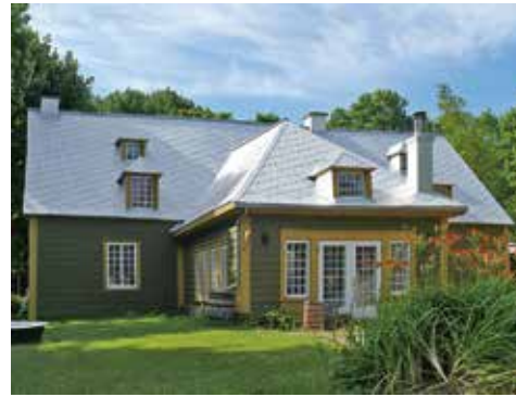
Manoir Allsopp doté d'une toiture en tôle à la canadienne, Cap-Santé
