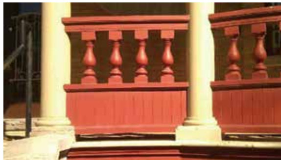
Deux principales manières de surhausser un garde-corps à 42 pouces : 1) L'ajout d'une base pleine sous le garde-corps existant (photo du haut); 2) L'ajout d'une deuxième main courante dans la partie supérieure (photo du bas).
