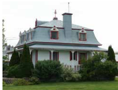
Maison dotée d'une toiture en tôle embossée, Pont-Rouge
