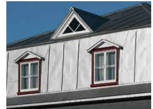
Tôle pincée et rivetée, une particularité locale de Saint-Marc-des-Carières
