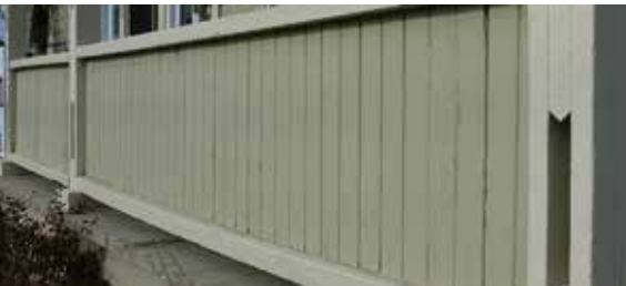
Garde-corps en bois plein, Saint-Ubalde
