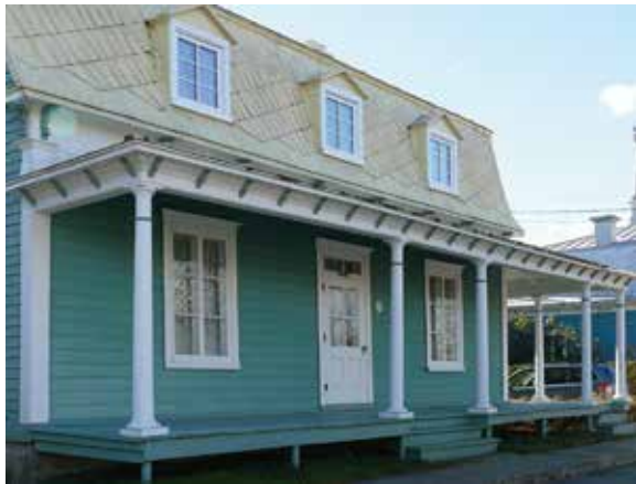
Une galerie régulièrement repeinte ne nécessite presque jamais de réparations majeures, Saint-Casimir
