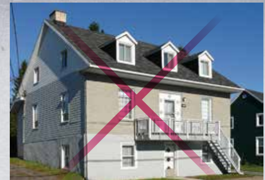
Maison ayant perdu l'ensemble de ses ornements, ce qui appauvrit le paysage bâti
