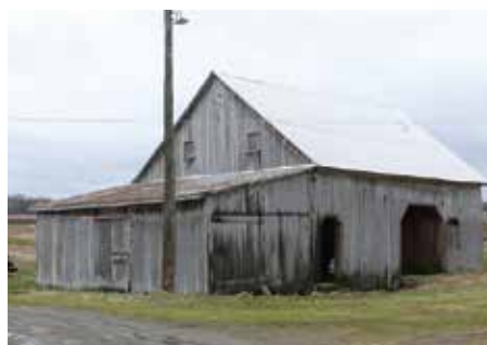
Bâtiments agricoles agrandis grâce à l'ajout d'appentis, Cap-Santé et Saint-Casimir
