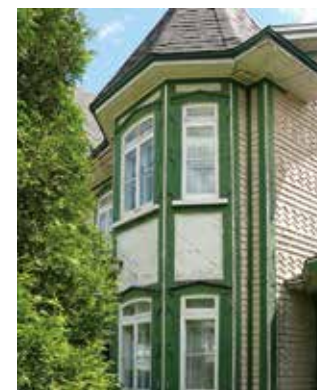
Maison éclectique munie de chambranles, Pont-Rouge
