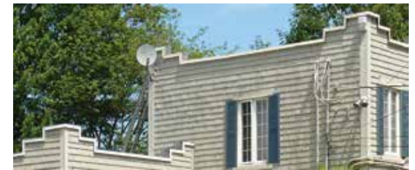
Parapet à gradins, Neuville
