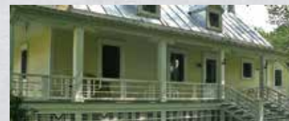
Jupes de galerie qui camouflent les fondations
