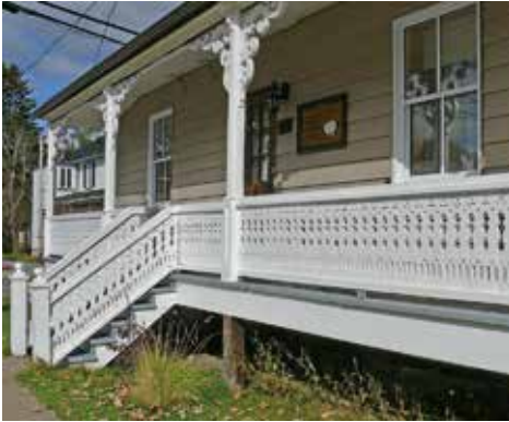
Garde-corps en bois découpé, Deschambault
