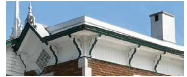
Corniche à consoles en bois, Saint-Basile
