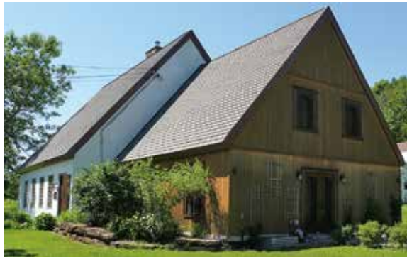
L'intégration d'un volume annexe par mimétisme, c'est-à-dire qui reprend les caractéristiques du bâtiment principal, mais avec des dimensions réduites, est une solution à privilégier pour un agrandissement. Cap-Santé
