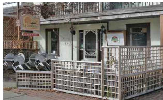
Terrasse aménagée devant une boulangerie, Deschambault
