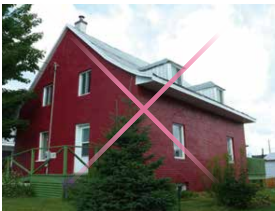
Maison dont la porte a été condamnée sur la façade principale, ce qui altère considérablement sa composition architecturale
