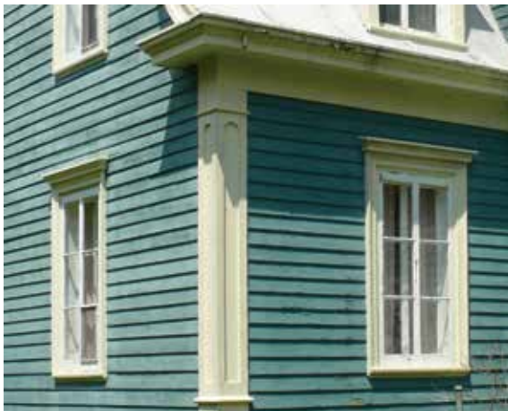
Planche cornière ouvragée, Deschambault
