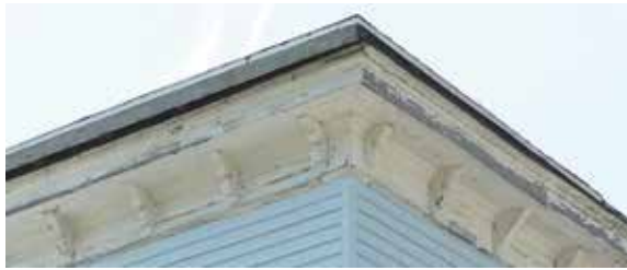
Corniche à consoles en bois, Rivière-à-Pierre
