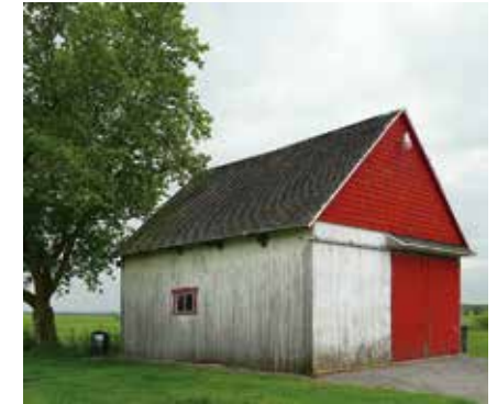
Hangar à machinerie, Pont-Rouge
