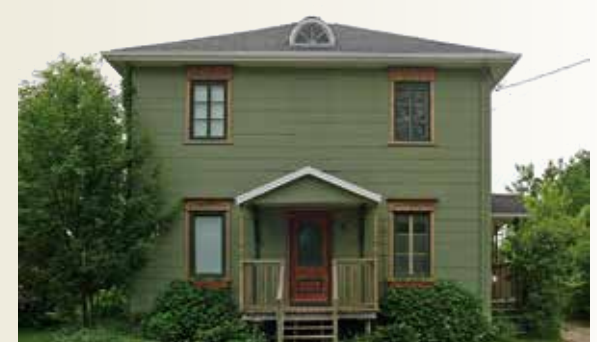
Maison revêtue de bardeaux d'amiante-ciment rectangulaires, Sainte-Christine-d'Auvergne
