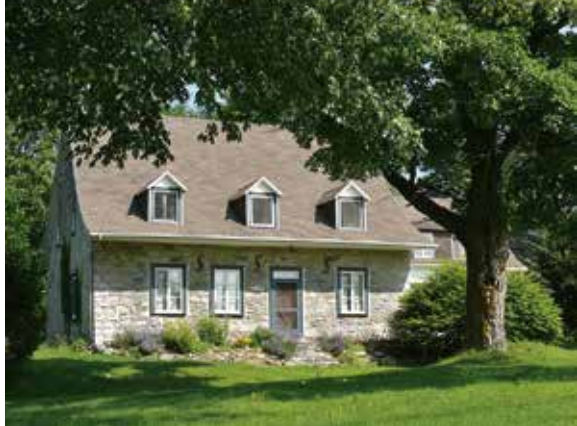
Maison traditionnelle dont les murs sont constitués de pierre à moellons grossièrement équarrie, Neuville
