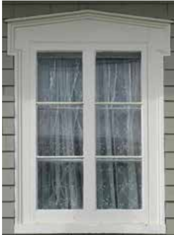
Fenêtre à battants à grands carreaux, Portneuf
