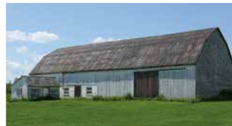
Grange-étable à toit brisé, Deschambault
