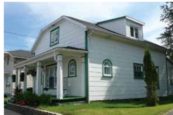
Maison revêtue de bardeau d'amiante-ciment, Donnacona
