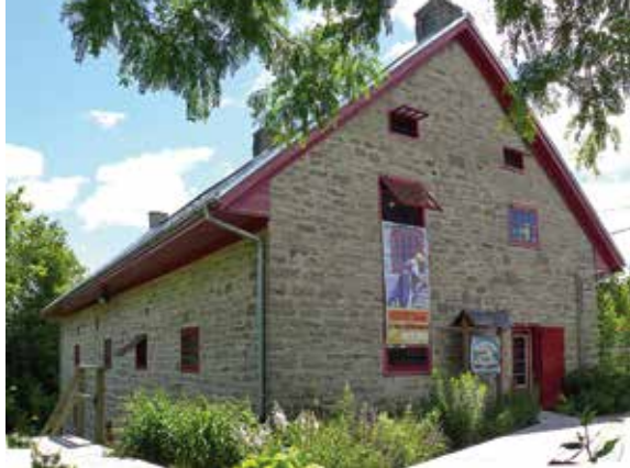
Le moulin Marcoux est entièrement construit en pierre à moellons. Pont-Rouge
