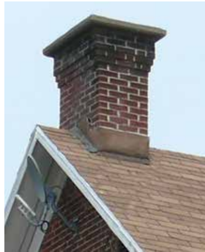
Cheminée en brique, Saint-Casimir
