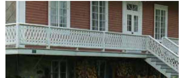
Garde-corps en bois avec barrotins découpés, Deschambault
