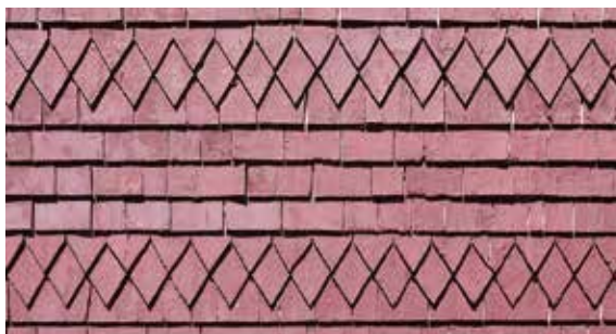
Revêtement de bardeau découpé, Cap-Santé
