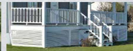
Nouvelle fondation en béton trop haute qui modifie de façon importante la volumétrie de la maison. À éviter
