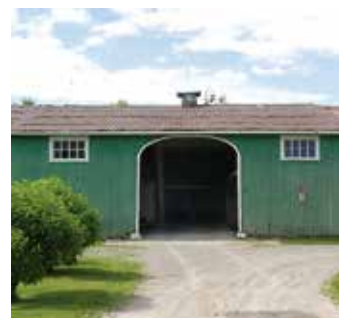
Ouverture cintrée et lanterneau, Pont-Rouge
