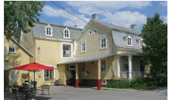
Terrasse aménagée au sol, Deschambault
