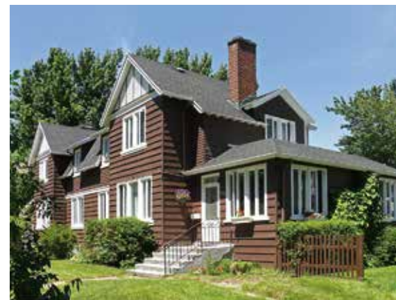
Bâtiment d'influence Arts and Crafts à la volumétrie très articulée avec avancées et pignons, Donnacona
