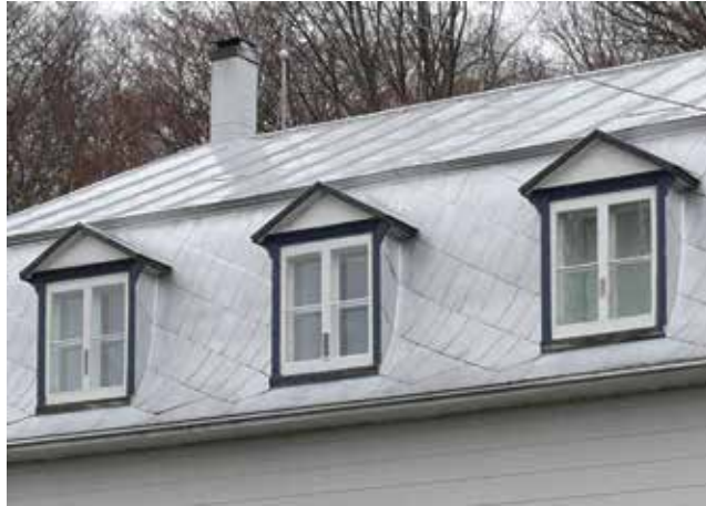
Lucarnes à pignon perçant le brisis d'un toit mansardé, Saint-Alban
