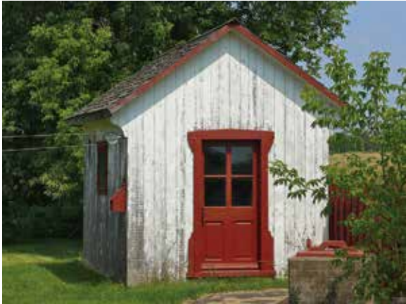
Remise en bois qui reprend certains détails architecturaux de la résidence, Grondines
