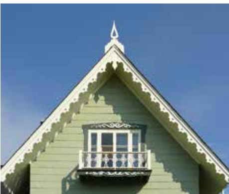
Bordure de rive en bois découpé et épi ornant la toiture de cette maison, Neuville
