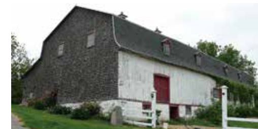
Grange-étable à toit brisé, Neuville
