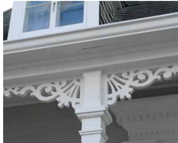
Aisseliers décorant une galerie, Deschambault
