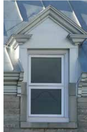
Lucarne pendante à fronton interrompu, Saint-Marc-des-Carières
