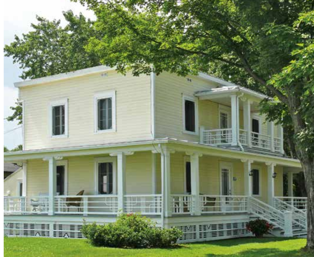
La préservation de la finesse des détails de ces galeries n'est possible que si le bois est peint et protégé de l'humidité. Deschambault
